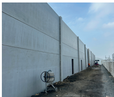
Mur anti-effondrement, bâtiment 1
